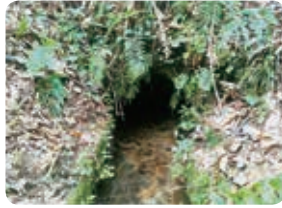
水穴口の取入口
